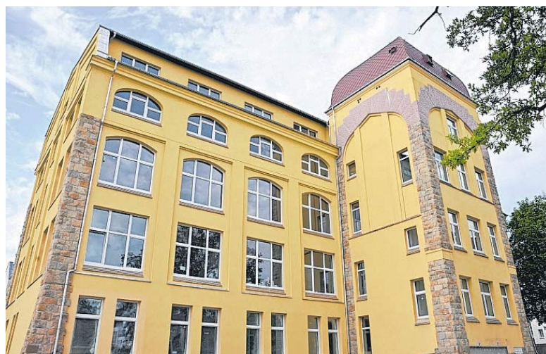
2021 begannen die Bauarbeiten in der ehemaligen Fabrik. Seit 2022 ist sie eine Schule.
